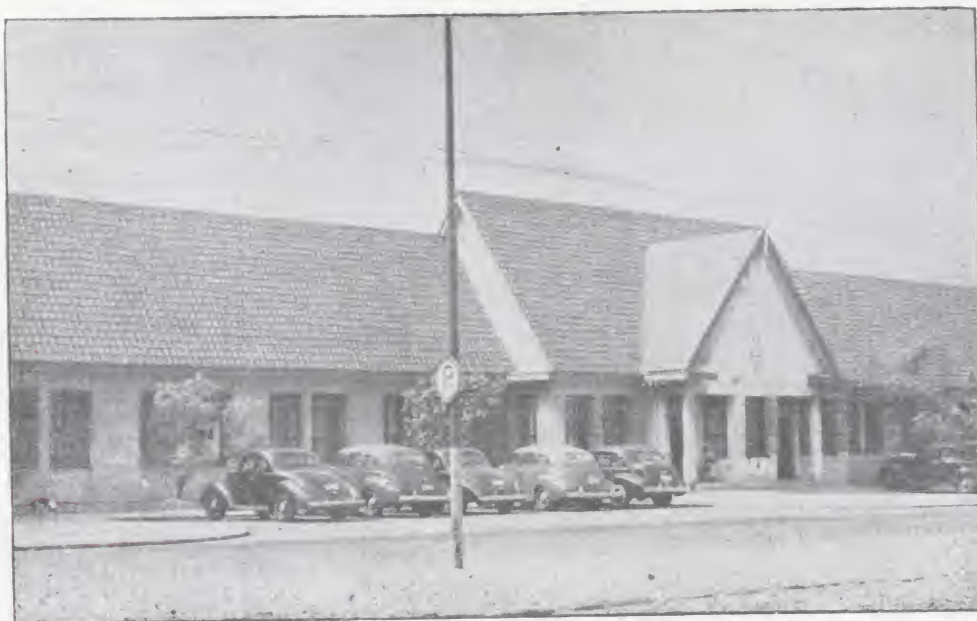
Edificio ocupado por el Cuartel de la Policía, en San Nicolás.
